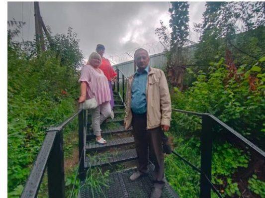
Устройство пешеходной лестницы по адресу: с. Октябрьский, ул. Заречная, около д. 49
