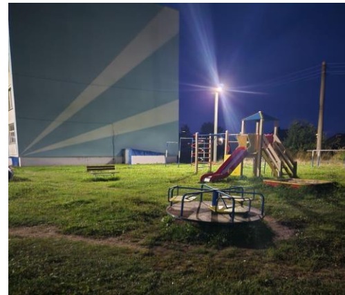
Устройство уличного освещения по адресу: с. Станко у д.4
