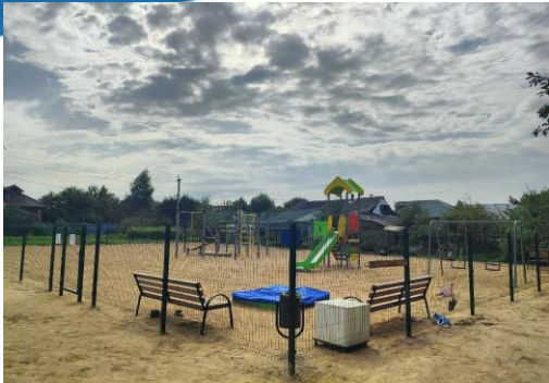
Устройство спортивно-игровой площадки по адресу г. Наволоки, ул. Кирова
