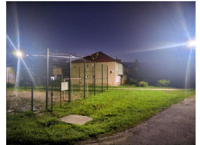
Устройство уличного освещения по адресу: г. Наволоки, ул. 8 Марта у д.10
