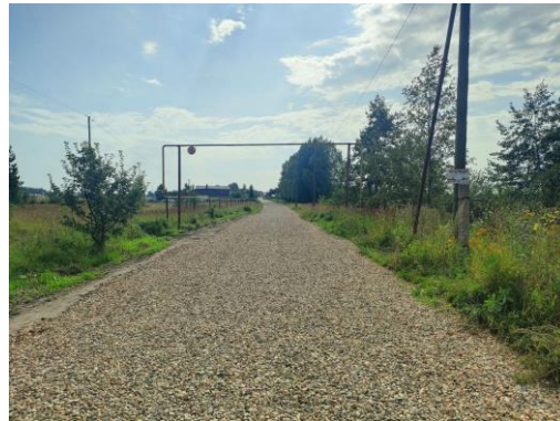
Отсыпка щебнем улицы Центральная д. Долгово
